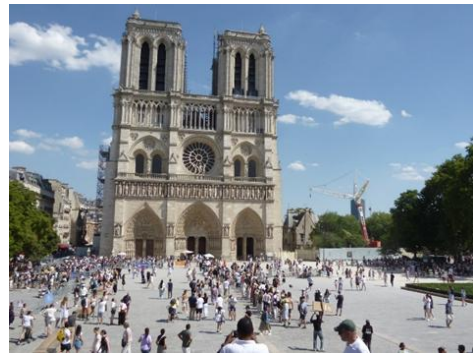
一部工事の続くノートルダム寺院
